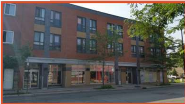
2432, AVENUE DU MONT-ROYAL E. 24 LOGEMENTS
